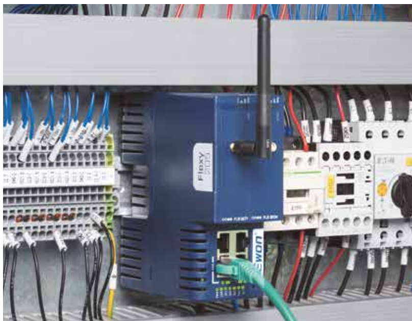
Router je kompaktní a v zájmu úspory prostoru je umístěn v rozvaděči stroje
